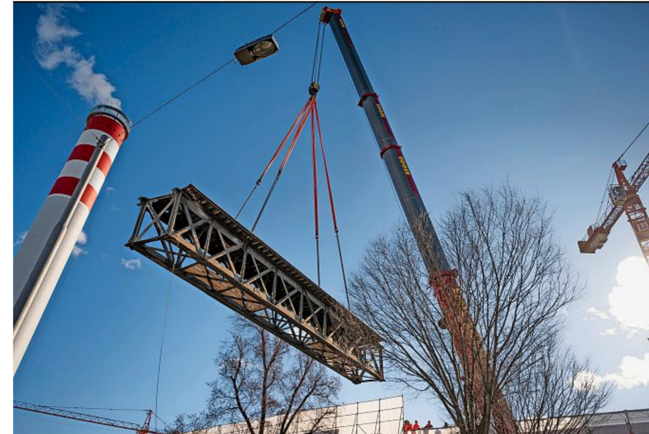
Ein Kran transportiert die Brücke über der Neugasse beim Viadukt ab. Geplant ist, dass sie in rund zwölf Wochen wieder eingesetzt wird. Fotos: Urs Jaudas
